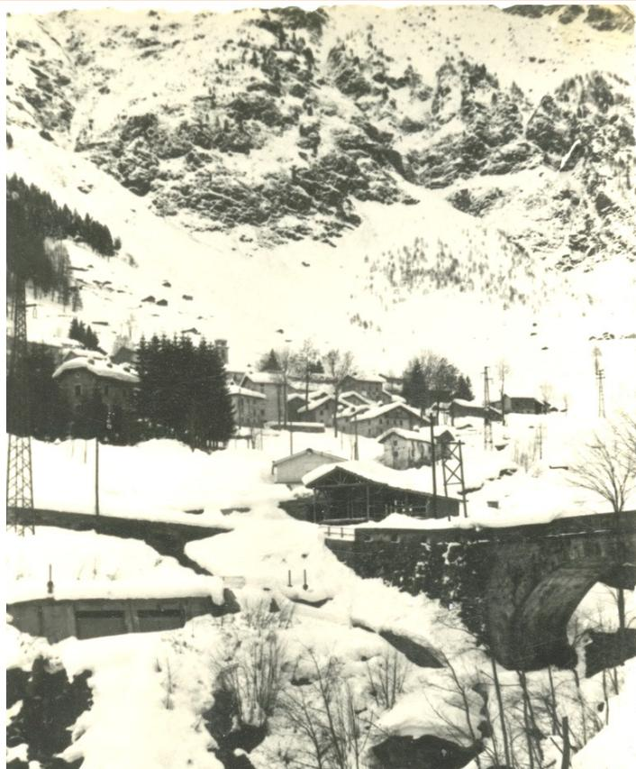
Foto di Fraciscio della fine degli anni cinquanta. Interessante perché si vedono in zona ponte i capannoni e i tralicci della teleferica piccola utilizzata per costruire la teleferica grande per portare il cemento in Val di lei per la costruzione della diga.
